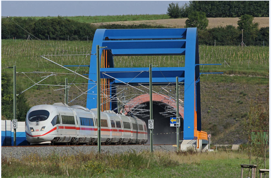
Ausfahrt Tunnel Eierberge mit Flutmuldenbrücke des Projektes VDE 8 Berlin-München. (Deutsche Bahn AG / Claus Weber)
